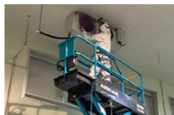
▲空調機洗浄作業
