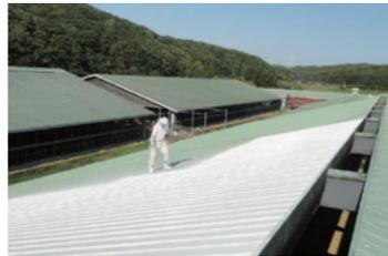
北海道の畜舎遮熱塗装施工時の様子
